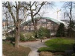
Gare en construction
